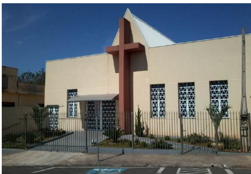
“Capela São Benedito”, do Jardim Vista Alegre, localizada na Rua Eneide Bocatto de Barros (tem entrada, também, pela Avenida Antonio Moraes de Barros)
