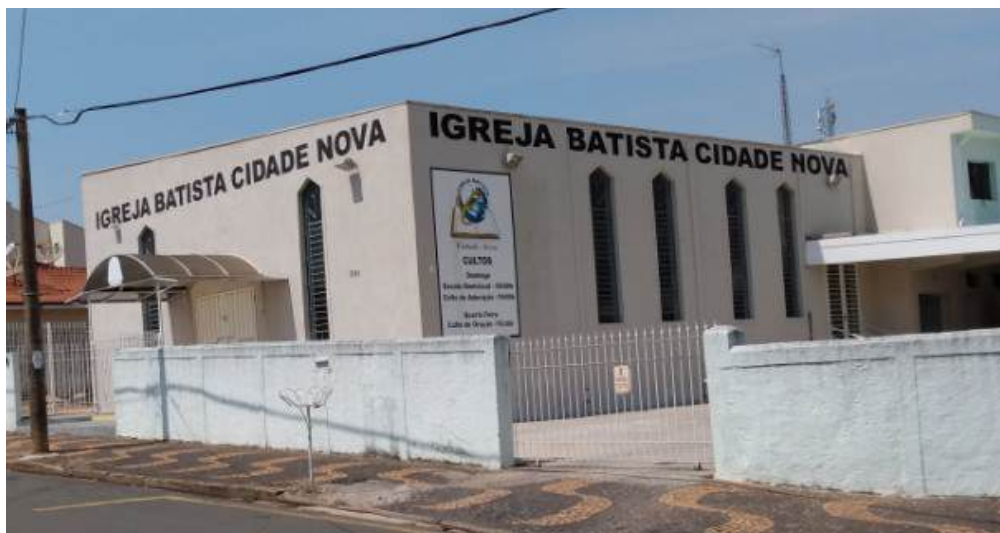
“Igreja Batista”, localizada no bairro Cidade Nova”, na Rua Rio de Janeiro, esquina com a Rua do Linho
